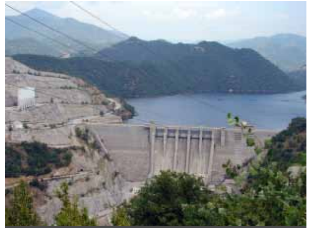
Εικόνα 11: Το φράγμα της Πλατανόβρυσης
