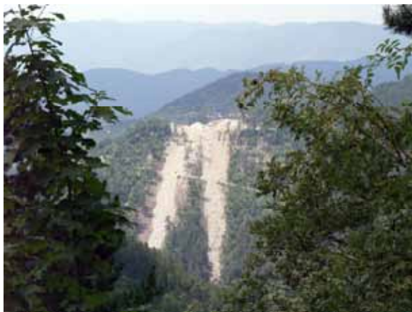
Εικόνα 17: Εκτεταμένες καταστροφές από τη λήψη χαλικιών για την ασφαλτόστρωση δασικών δρόμων
